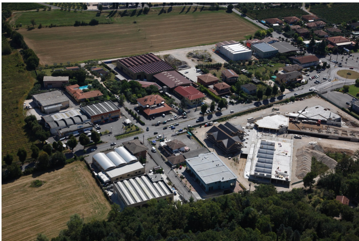
Vista aerea Est-Ovest –foto inserimento
