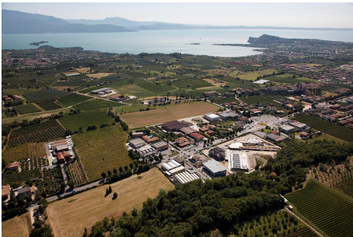
Vista aerea Ovest-Est – stato di fatto
